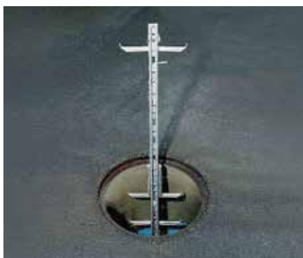
Автодорога. Лестница для спуска в коллектор. Вертикальная рельсовая анкерная линия Глайдлок со съемным удлинителем
