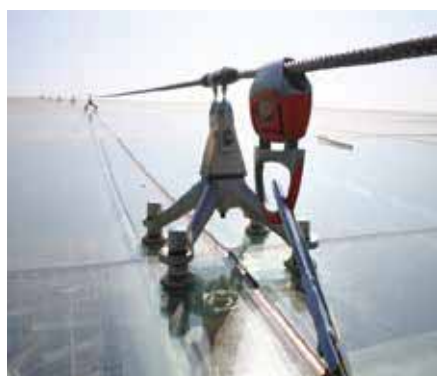
Стеклянная кровля торгового центра. Горизонтальная тросовая анкерная линия Ксенон
