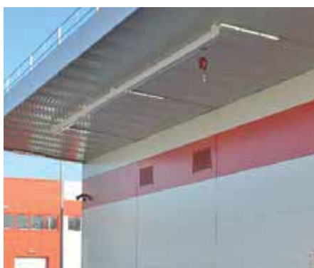
Завод производства масел. Автомобильная эстакада налива. Горизонтальная рельсовая анкерная линия Мультирейл
