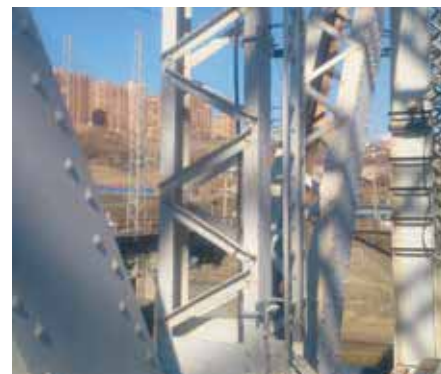
Опора ЖД моста. Вертикальная рельсовая анкерная линия Глайдлок с интегрированной лестницей
