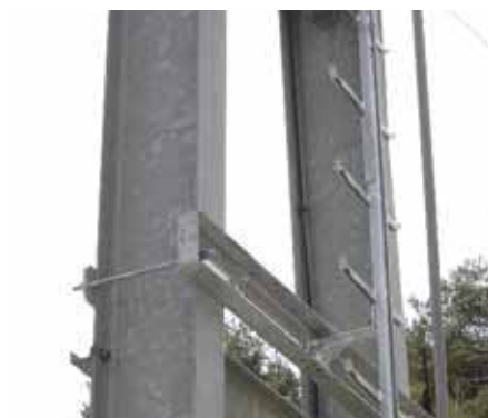
Электростанция. Портальная опора. Вертикальная рельсовая анкерная линия Глайдлок
