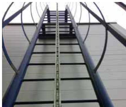
Пищевое производство. Лестница подъема на кровлю цеха. Вертикальная рельсовая анкерная линия Глайдлок
