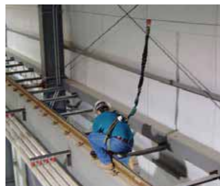
Производственное здание. Крановый путь. Горизонтальная тросовая анкерная линия Ксенон
