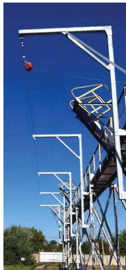
Нефтебаза. ЖД эстакада налива. Горизонтальная тросовая анкерная линия Ксенон
