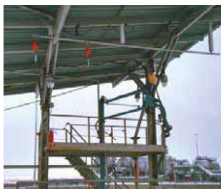
Нефтебаза. Автомобильная эстакада налива. Горизонтальная рельсовая анкерная линия Мультирейл
